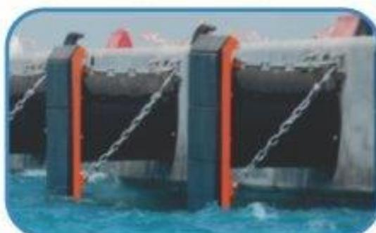
Los paneles van además soportados por cadenas, que sirven para soportar el peso del mismo así como para mantenerlo paralelo a la línea del muelle.
