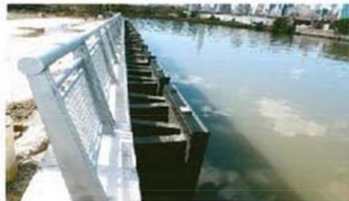
Basicamente las defensas fijas consisten de soportes de jebe fijas al muelle, con paneles frontales de material marino plástico, conocido como UHMW-PE, cuya combinación hace una amortiguación adecuada. Los hay de diversos tamaños y resistencias.
